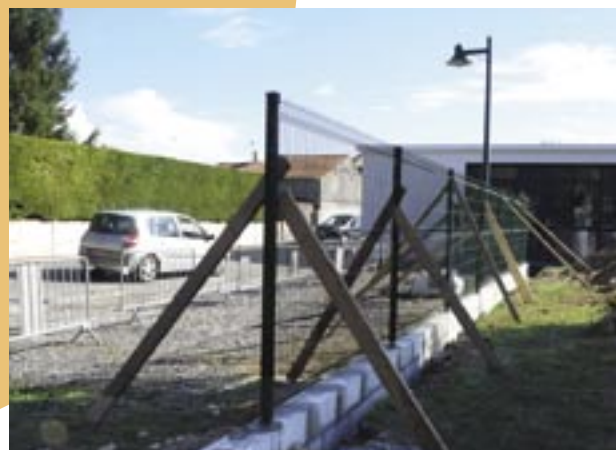
Écoles, bibliothèque et ALSH : la clôture obligatoire (plan Vigipirate) est en cours de réalisation.
