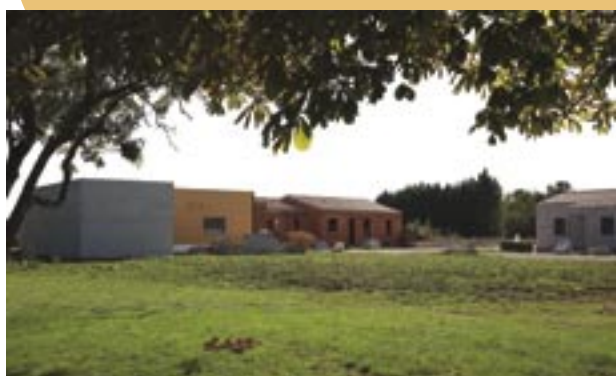
Lotissement communal : toutes les parcelles sont pratiquement vendues. Les travaux de construction vont bon train.
